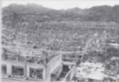
三浦大橋の被爆状況
